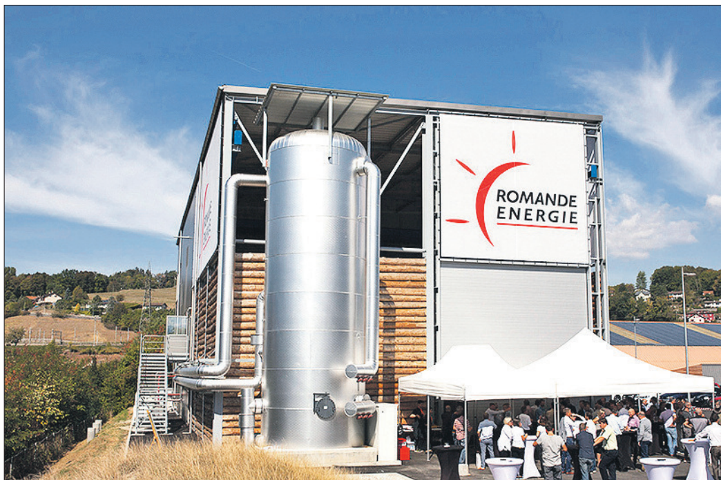
CENTRALE THERMIQUE. Un peu moins de deux ans auront été nécessaires pour la mise en service de l'installation située à Puidoux, dans le canton de Vaud.
